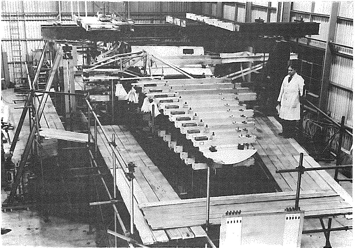
FIG. 4 "MOSQUITO" WING TEST RIG
