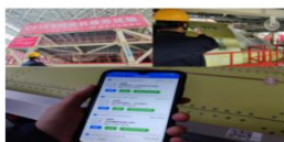
数字化检测 现场实施
